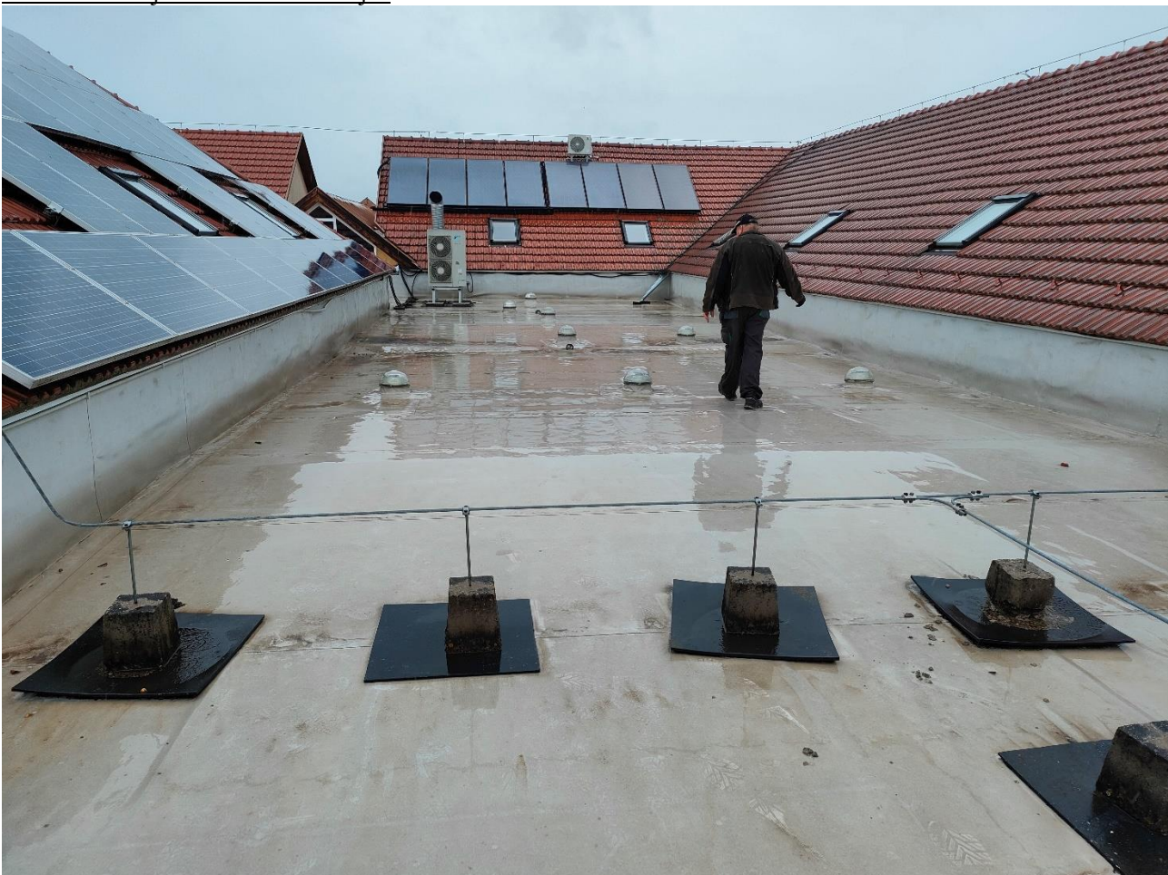
Vászon borítás javítása az óvoda tetején
