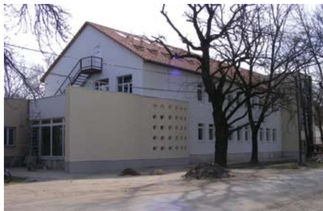
A felújított, volt gimnázium épülete
